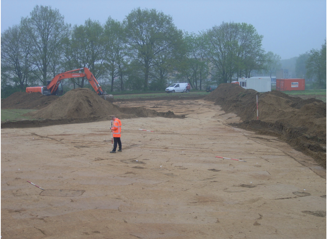
Afb. 1.1 Werkzaamheden in de werkputten 107 en 108.
